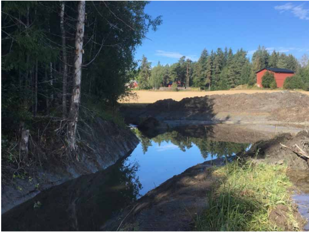
Kuva 29 Römossebäckensin pieni kosteikko kaivuutöiden jälkeen syyskuussa 2020
