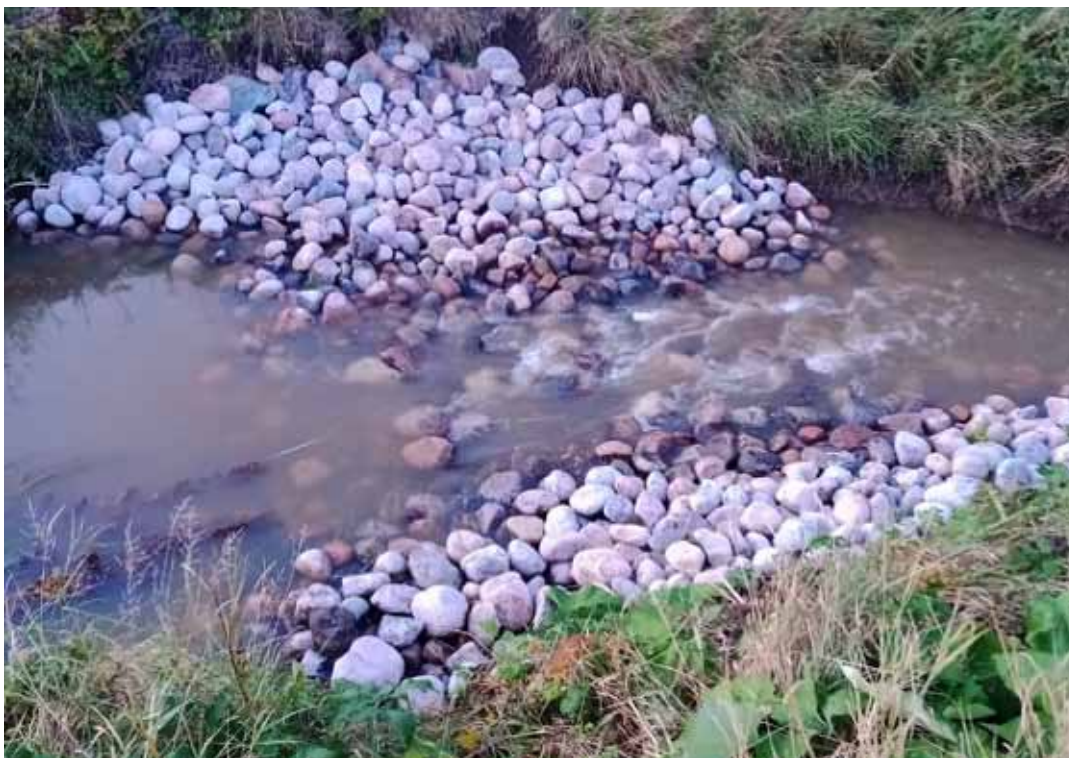
Kuva 25 Valmis pohjakynnys Bocksbäckenin uomassa, kuva: Carl-Erik Grönroos, C-E Grönroos Oy Ab
