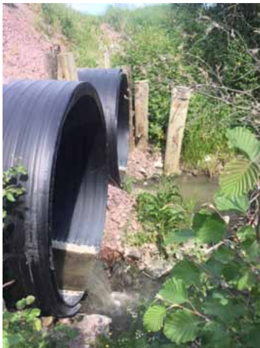
Kuva 4 Liian korkealle asennetut tierummut Myransbäckenillä Siuntionjoen valuma-alueella, kuva: Jenny Jyrkänkallio-Mikkola
