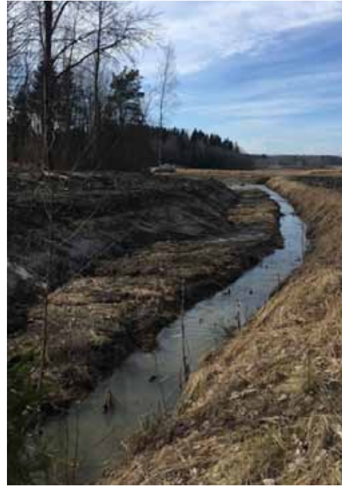
Kuva 15 Krabbrödjanin vastarakennettu kaksitasouoma maaliskuussa 2020, kuva: Jenny Jyrkänkallio-Mikkola
