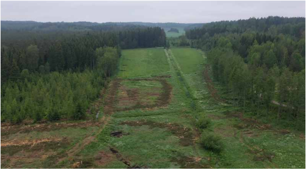
Kuva 8 Söderlandintien kosteikkoalue ennen rakentamista puiden kaadon jälkeen heinäkuussa 2019. Kuva: Helsingin yliopisto Geotieteiden ja maantieteen osasto
