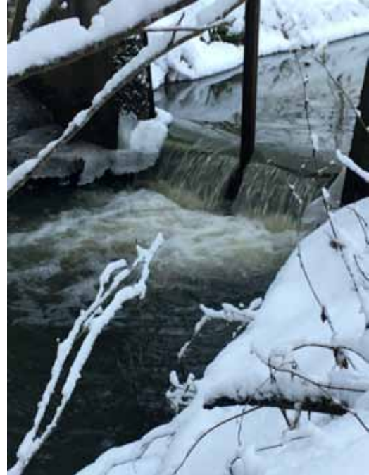
Kuva 2 Vanha patorakennelma Inkoonjoessa, kuva: Jenny Jyrkänkallio-Mikkola
